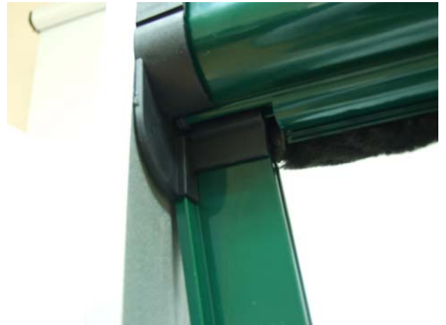
6 Inserimento guida senza forare copritestata
