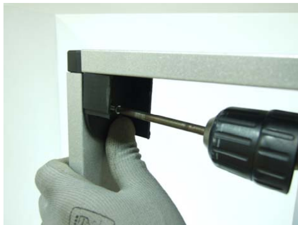
2 Fissare il copritestata dx-sx con un solo foro per lato
