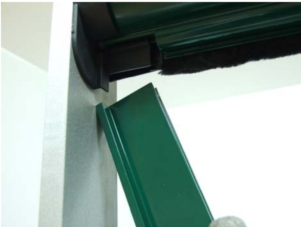
6 Inserimento guida sx senza forare copritestata
